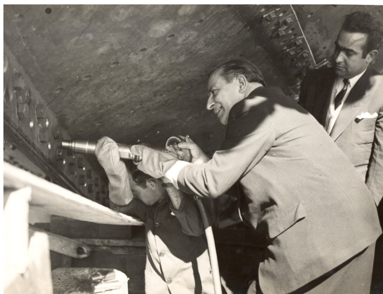
Foto 8 - Bissaya-Barreto cravando o primeiro rebite no arrastão com o seu nome construído nos Estaleiros Navais do Mondego. Ladeado, à direita, pelo Arq.º Luís Viegas Nascimento, 1950.
